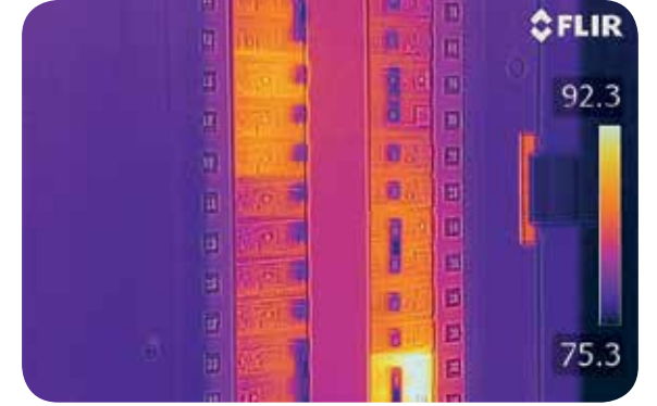
E8 MSX İLE ELEKTRİK PANOSU
