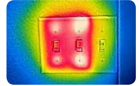
C2 AŞIRI ISINMIŞ DUVAR PRİZİ
